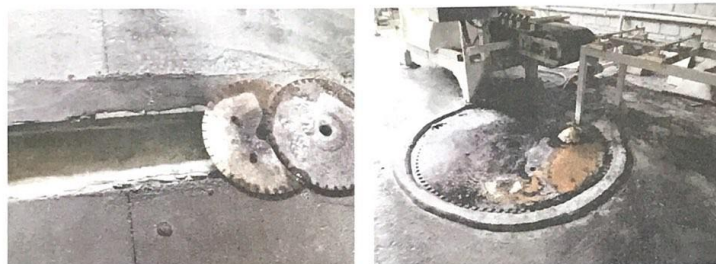
图 3-1 生产废水导流渠、沉淀池
