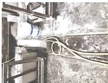
沉淀池和循环水泵、生产废水导流渠
