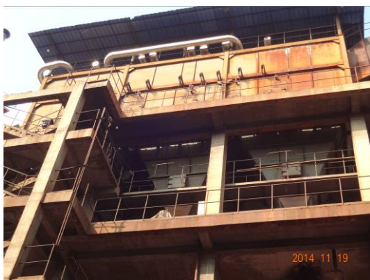
20t/h 的混合循环横向冲刷式中压余热锅炉
