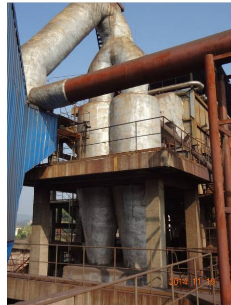
旋风除尘器（与沸腾炉配套）
