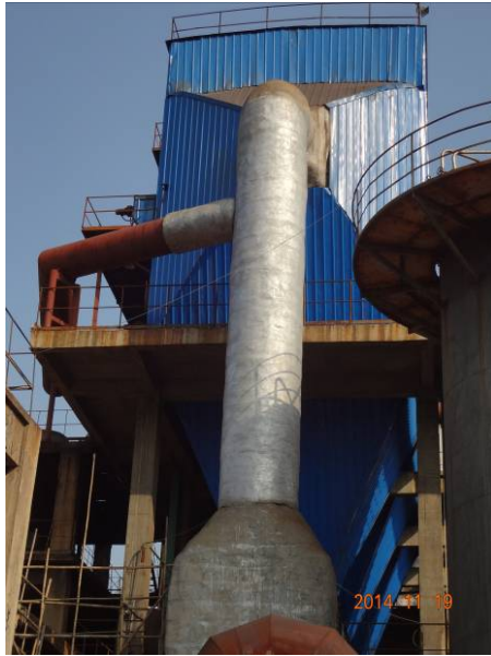
电除尘器（与沸腾炉配套）
