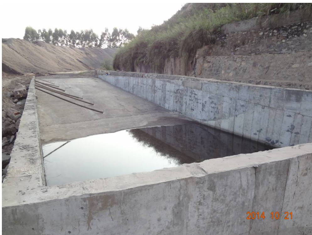
图 3-8 硫铁矿烧渣堆场沉淀池
