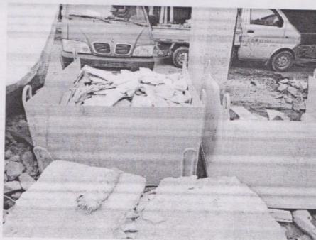
图3-3固体废物临时堆放设施
