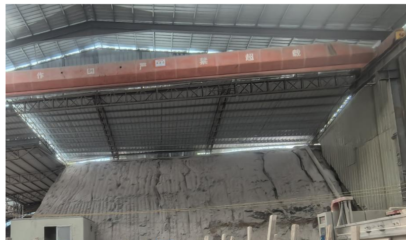
项目东南面：紧邻自然山体
