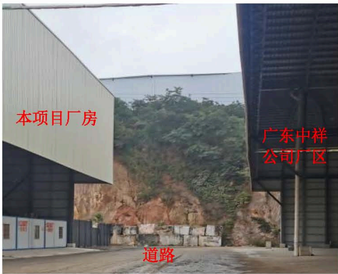
东北面为道路
