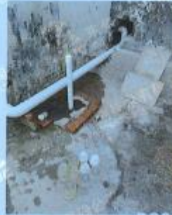
氯化钾车间门口处
