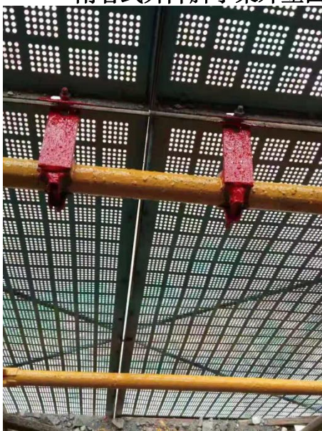
冲孔金属板安全网固定实体图
