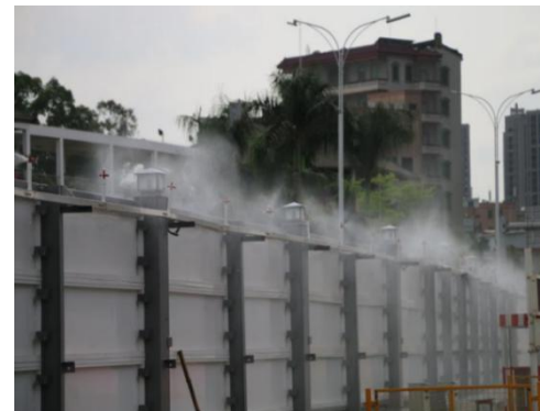
围挡喷雾示例图
