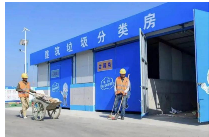
建筑垃圾分类示例图
