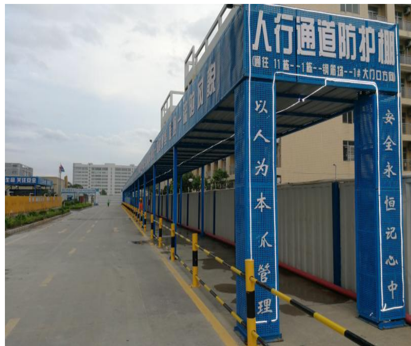
人车分流通道防护示例图
