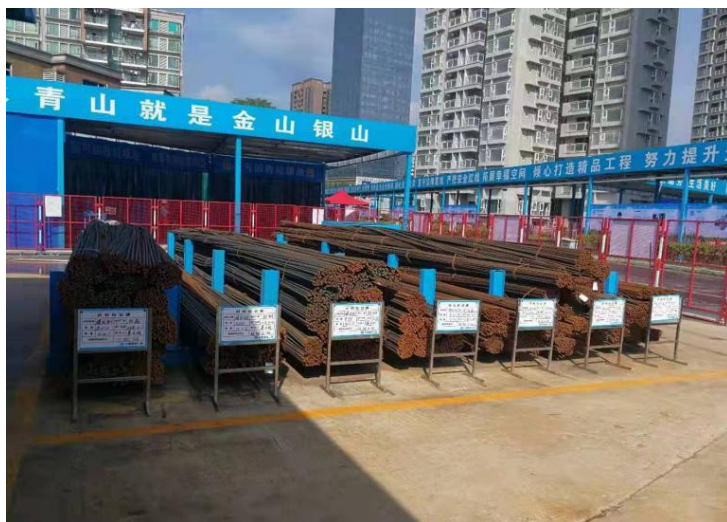
钢筋堆放示例图
