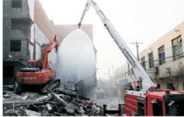
拆除工地 100%湿法作业示例图
