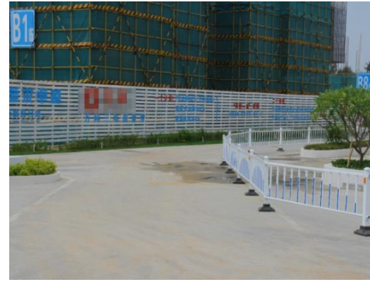
施工现场硬化示例图
